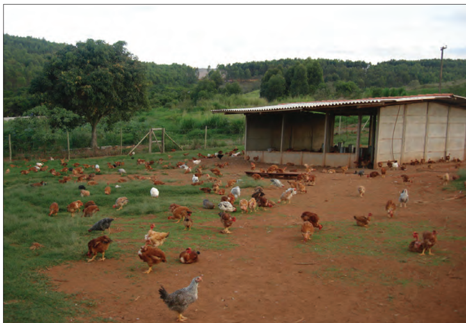
Figura 3 - Galpão rústico, com paredes de proteção construídas com placas de cimento pré-moldadas
