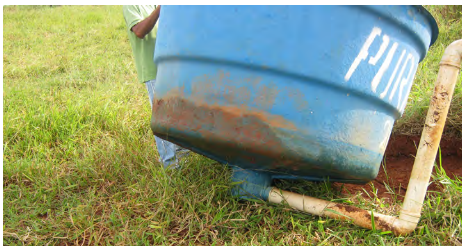
Figura 3 - Vista do fundo autolimpante da caixa d'água, com a caixa coletora, em fibra de vidro e o cano de saída da água
