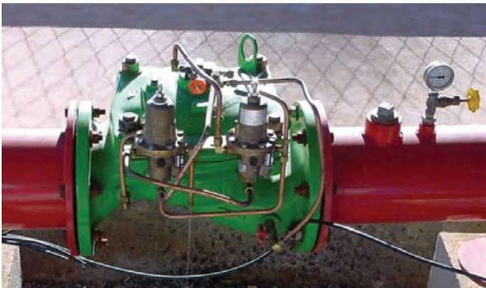
Válvula de controle de fluxo e manômetro
