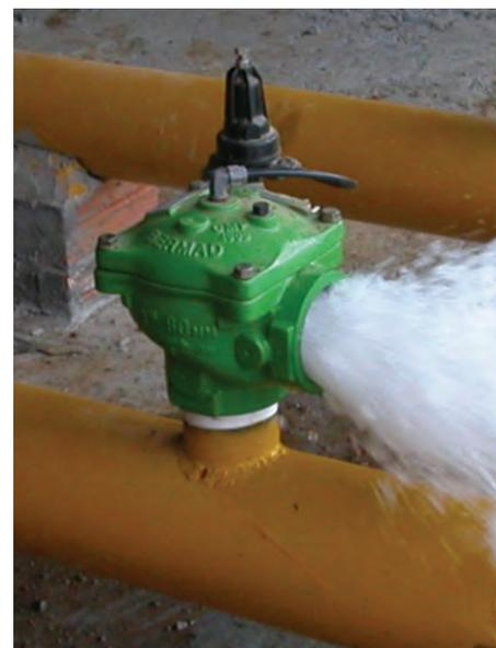
Figura 4 - Válvula de alívio de pressão em operação
