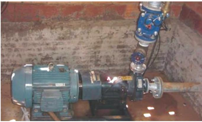
Motobomba e válvula reguladora de vazão
