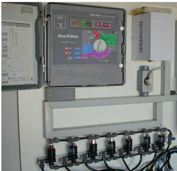
Figura 7 - Controlador digital com banco de solenoides de três vias
