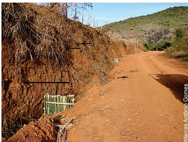
**Figura 61** - Paliçadas de bambu ao longo da estrada em Itabira, MG.
