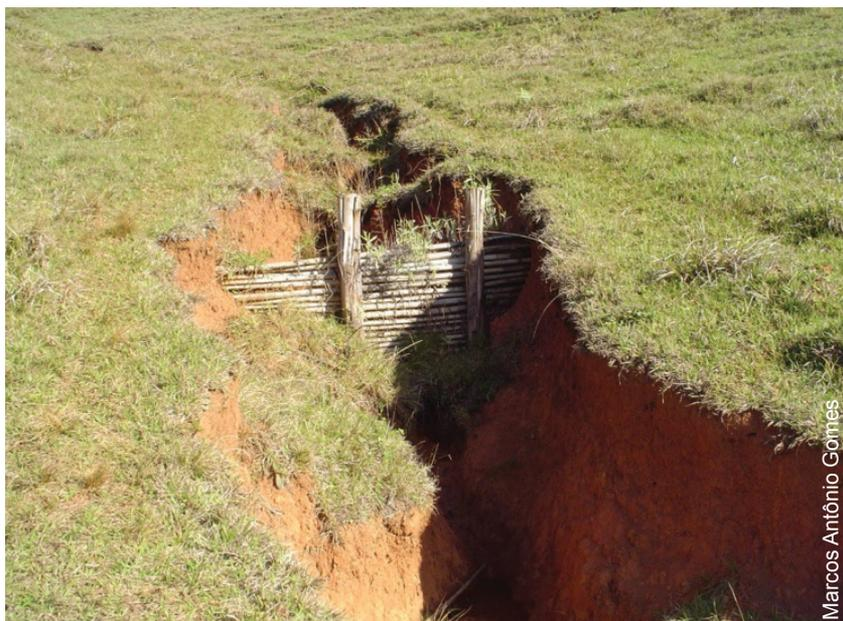
**Figura 49** - Paliçada dentro de uma voçoroca, Viçosa –MG.
