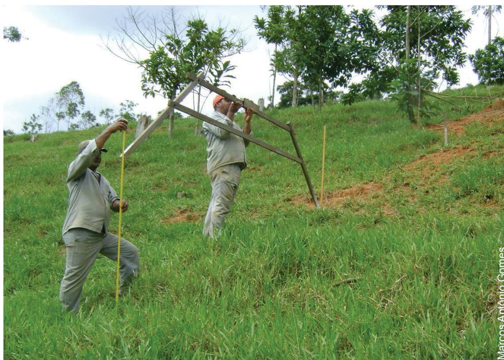
**Figura 25** - Modo de obtenção da diferença de nível, leitura da altura medida pela régua.
