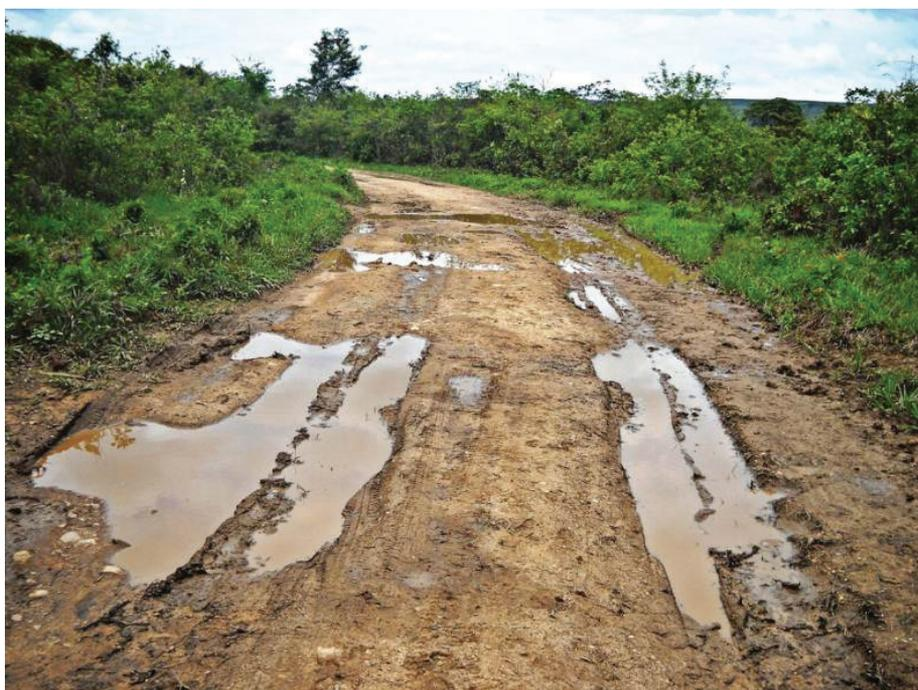
**Figura 54** - Estrada sem desnível e sem dispositivos de drenagem.
