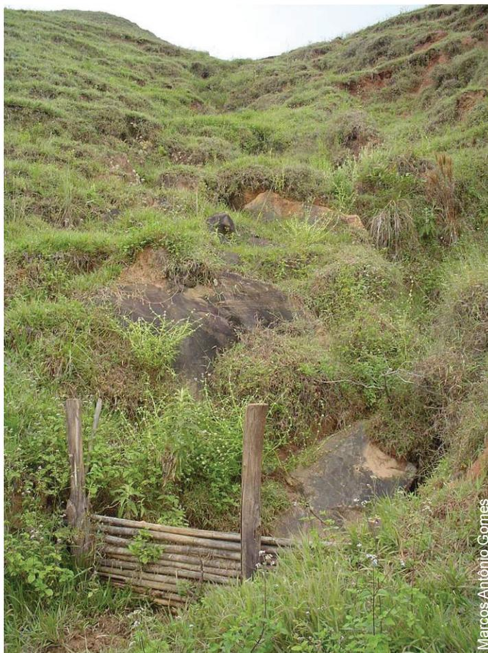
**Figura 50** - Paliçada construída na parte inferior da encosta para contenção do processo erosivo, Viçosa –MG.
