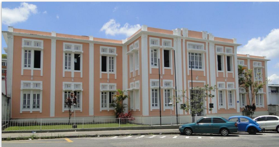
Fachada histórica da EPAMIG - ILCT
