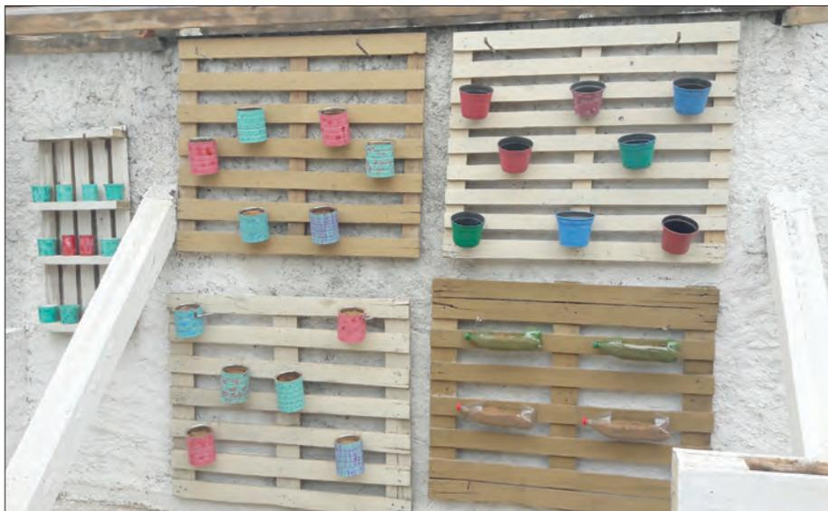
Figura 4 - Suportes apoiados em ganchos chumbados com cimento onde os vasos e diferentes tipos de recipiente são presos com auxílio de um arame
