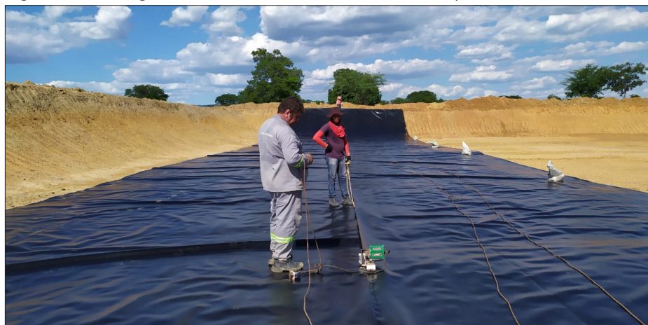
Figura 4 - Soldagem da lona de revestimento com máquina ultrassom
