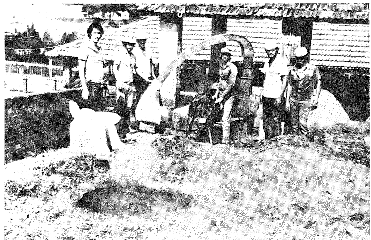
Foto 4 – Silo subterrâneo ESAL Lavras, MG.
