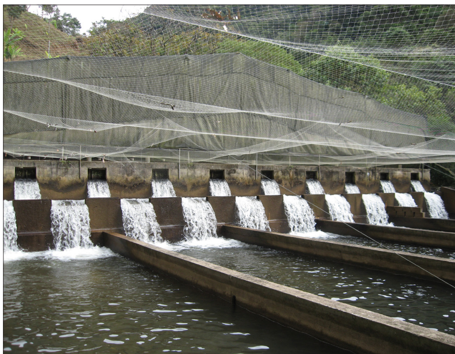
Figura 6 - Tanques em alvenaria tipo raceway - NR Truticultura, Sapucaí Mirim, MG
